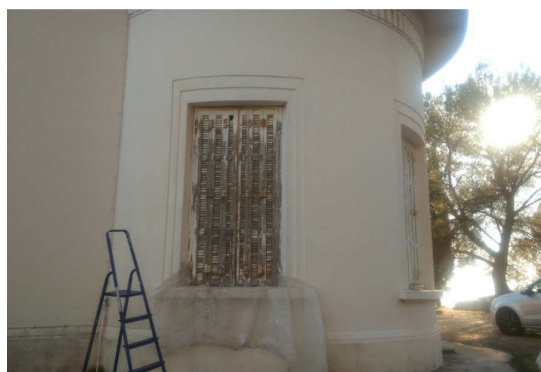
Volets Nord-est après ponçage
