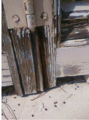
Partie inférieure du volet Sud-Est, en partie vermoulue
