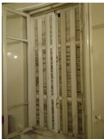
Depuis l'intérieur, on voit au centre la lame de bois verticale vissée sur le montant gauche.
