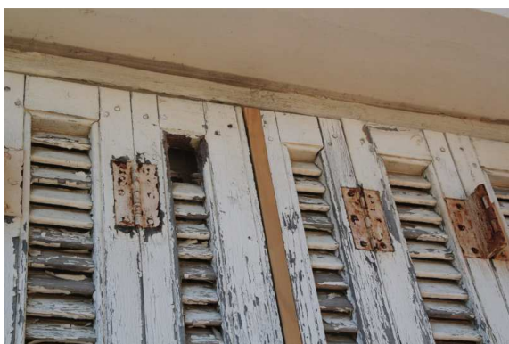
Lame de bois ajoutée au volet nord-est, avant peinture
